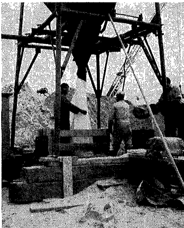
Het vullen van de zandzakken
