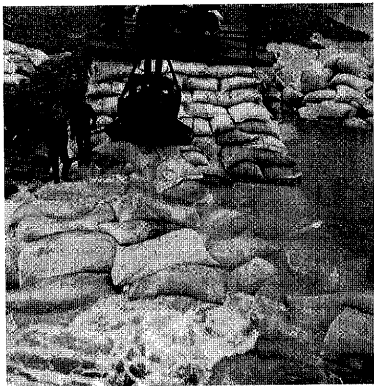
In het sluitgat is de stroom gebroken
