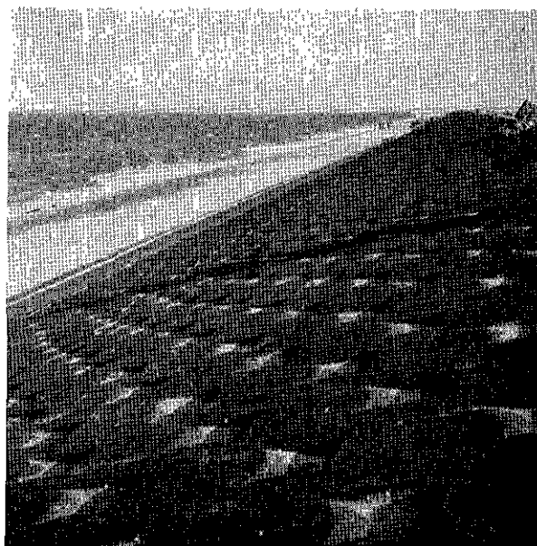
De bekleding van zandasfalt aan de westzijde van de bouwput is ter beperking van de golfploop tussen 5,50 m en 8 m + N.A.P. geprofileerd
